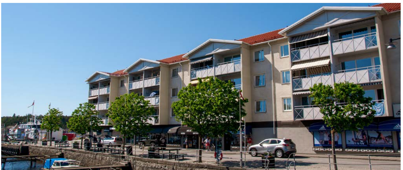
Kvarteret Fiskaren genomgår renoveringar under 2021 och 2022
